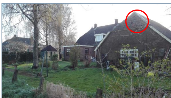
Foto 1. Potentieel geschikte nestlocatie voor de steenuil (schuur Donselaarsweg 8). Toegang tot het dak via een losliggende dakpan en/of de onderrand.
